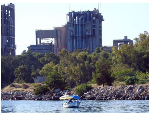
ribič pred opuščeno cementarno
