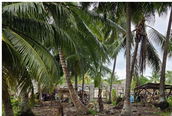
cerkev v izgradnji
