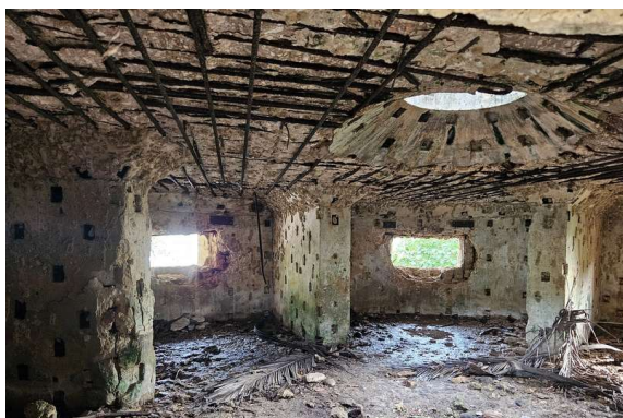
notranjost bunkerja-glede na maso turistov in po 80ih letih je še kar dobro ohranjeno
