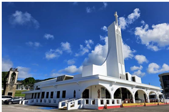
del stare cerkve zraven nove moderne
