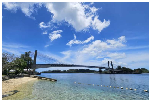
Most Koror-Babeldaob je most na Palauu, ki povezuje otoka Koror in Babeldaob. Gre za armiranobetonski, portalni okvirni, viseči most v skupni dolžini 413 m (leto 2002)
